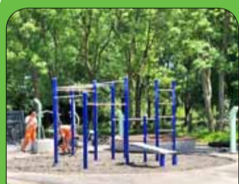
De fitnessstoelstallen zijn begin juni geplaatst.
